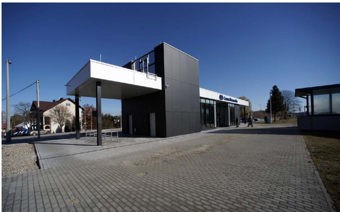
Dworzec w Czarnej Tarnowskiej z kubistyczną bryłą i wieżą zegarową
