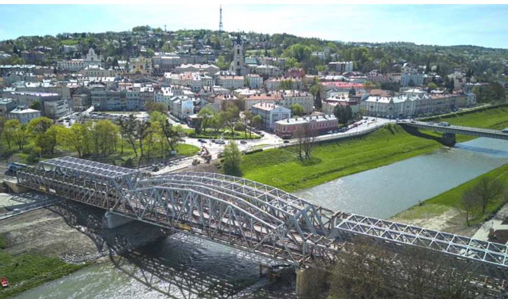
Most kolejowy w Przemyślu
